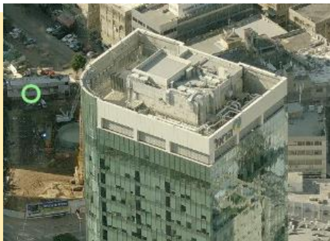
הסתרת מערכות טכניות בגג ע"י מעטפת חיצונית בחלק אינטגרלי מעיצוב הבניין
